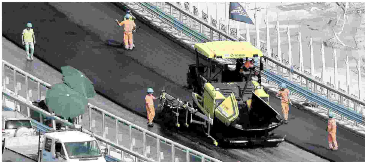
Un tratto del nuovo Ponte di Genova
